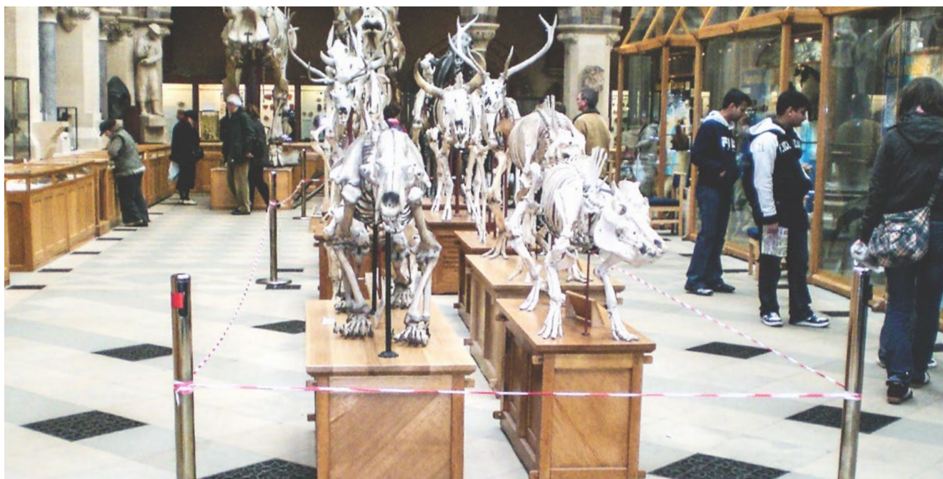
Warmluftheizungen sind prinzipiell für die Beheizung großer, historischer Räume geeignet – im Bild ein britisches Naturkundemuseum. Gut zu erkennen sind die vielen dunklen Warmluftauslässe, die in die Gestaltung des Fußbodens integriert wurden. Die Zuluftgeschwindigkeit ist so gering, dass sie von den Besuchern nicht wahrgenommen wird.
